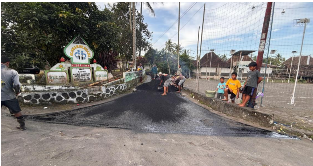
Pembangunan: Pengaspalan Jalan di Sapen.
