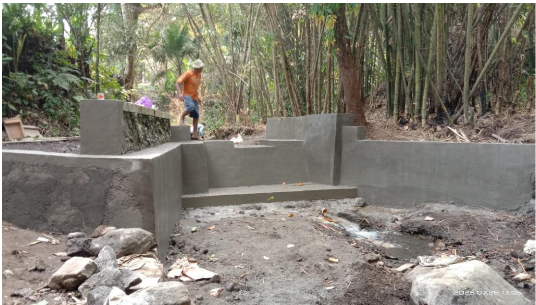
Pembangunan: Pembuatan Bendung Jomblangan II di Kalisoro.
