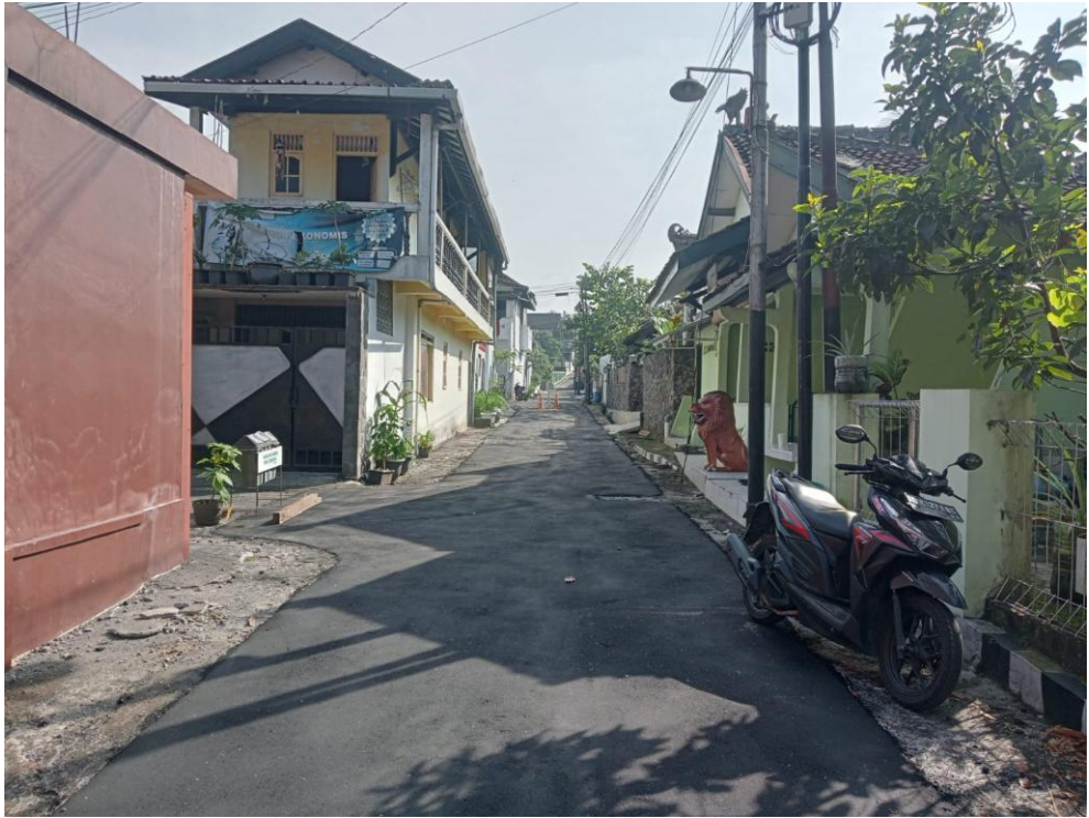
Pembangunan: Pengaspalan di Perum Pamungkas.
